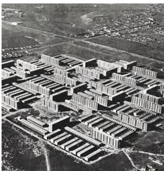
Orcasitas exemplifica bem o Plano de Remodelação do Bairro. Projetada em 1957, a Vila tinha um carácter experimental, elogiada pela sua conceção vanguardista; Mas a baixa qualidade dos materiais, as deficiências de construção e a falta de estudos geotécnicos causaram graves patologias nos edifícios.
